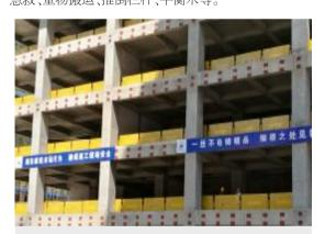
图:各楼层临边定型化防护栏
